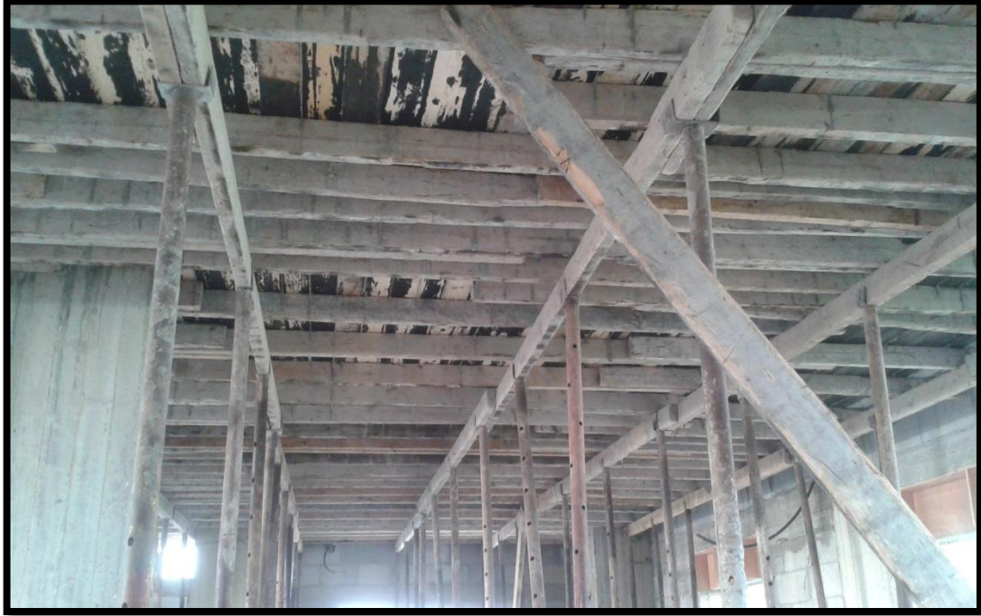
الشكل(7.2): صورة لنموذج الأسقف الخرسانية للمباني في فلسطين.
